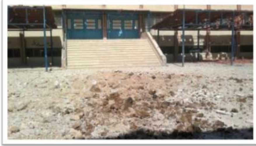
آثار القصف الذي استهدف إحدى مدارس مخيم الحسينية
