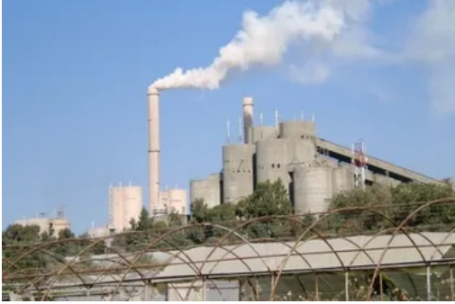
تخفيفاً للاحتقان مع غياب الكهرباء!!.. النظام يزعم وقف إمدادات الغاز لـ "معمل الأسمدة الروسي" بحمص
