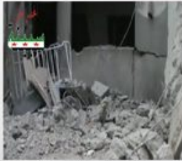
دمار كبير في بلدة سبينة جراء القصف بصواريخ غراد على البلدة
